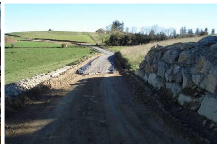
Mise en place du gravier
