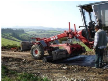
Pose du géotextile
