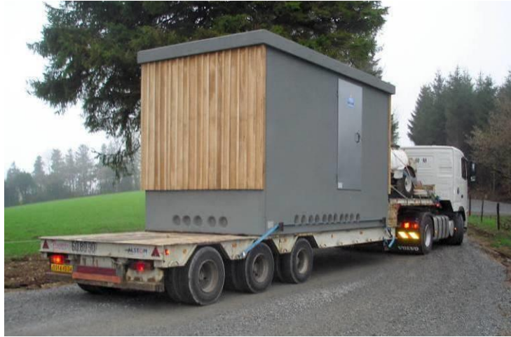
Arrivée d'un poste de livraison sur un site éolien
